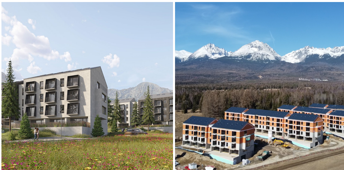
Obr.4: Vizualizácie prvej etapy a aktuálny stav jej výstavby
